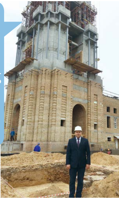
Евгений Ступин на строительной площадке Костромского кремля
